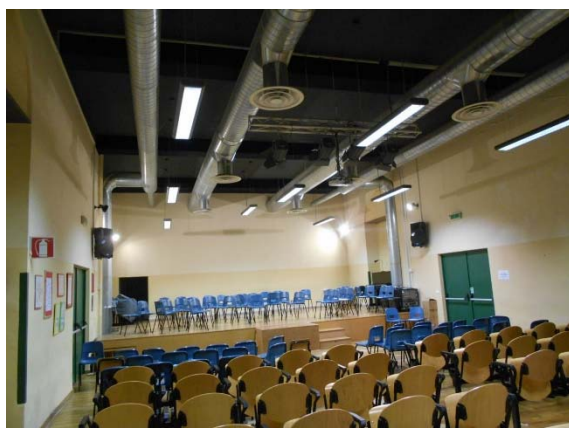
Figura 4.11 - Particolare delle strisce radianti ad acqua a soffitto nella palestra del primo piano
