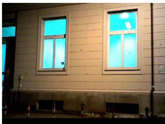
Figura 4.7 – Rilievo termografico dei serramenti
