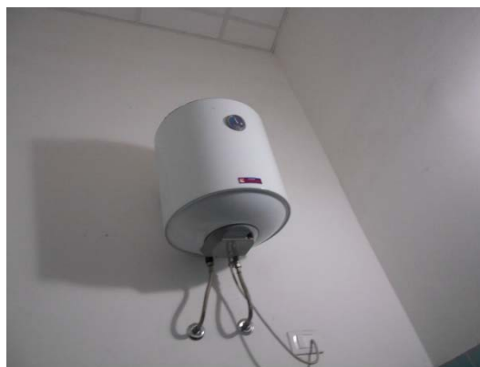
Figura 4.19 - Particolare di un boiler elettrico per la produzione di acqua calda sanitaria
