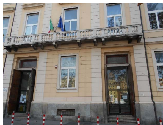
Figura 0.1 - Vista della facciata [esposta a Nord-Ovest]
