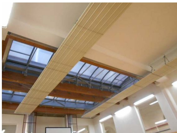
Figura 4.11 - Particolare delle strisce radianti ad acqua a soffitto nella palestra del primo piano
