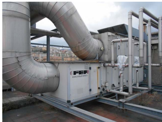
Figura 4.20 - Particolare del sistema di ventilazione meccanica controllata
