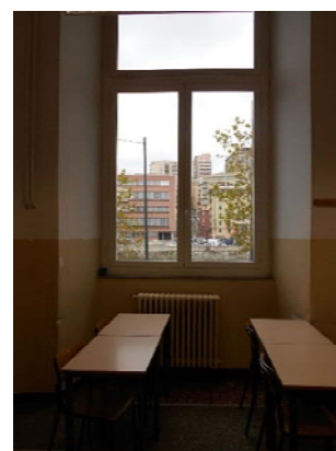
Figura 8.5 - Particolare di un infisso
