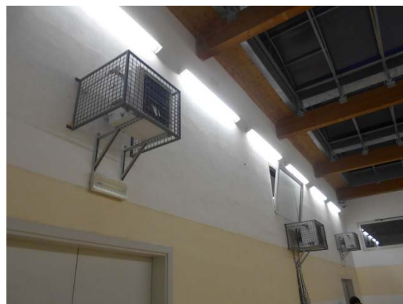
Figura 4.12 - Particolare degli aerotermi a parete nella palestra del secondo piano
